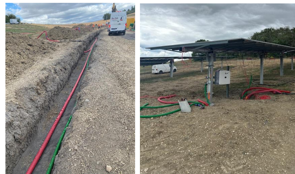
Figure 25 : Tranchées de câbles (source : TSE)
