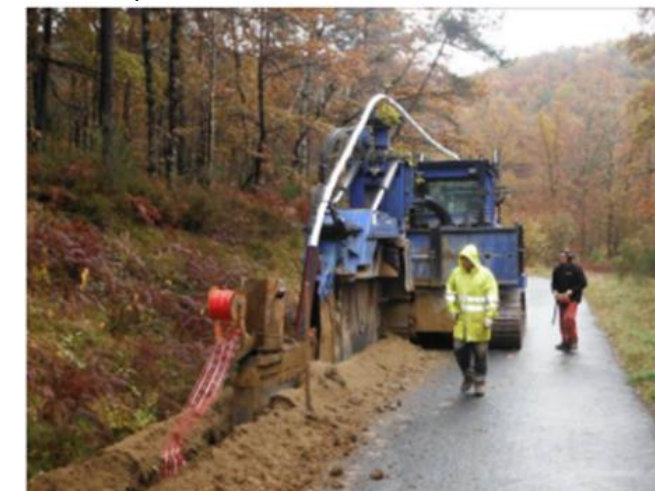
Figure 28 : Pose de câble à la trancheuse
