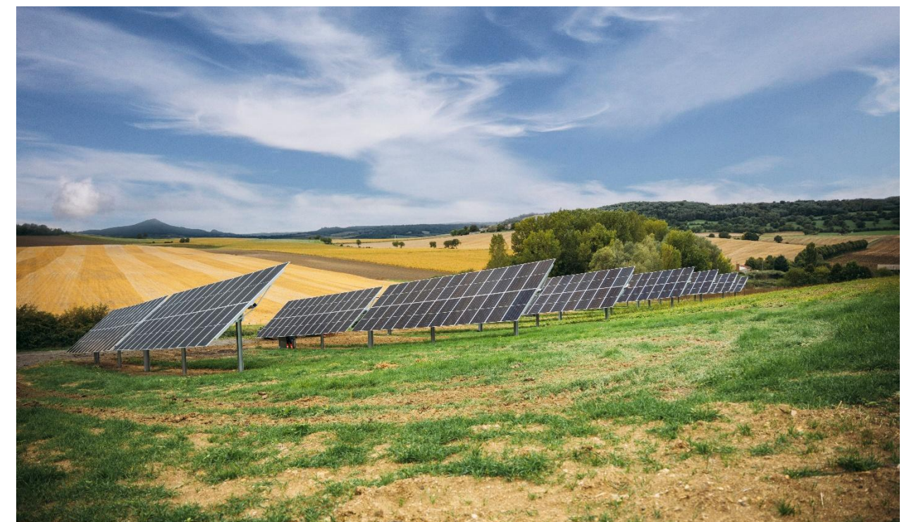
Figure 8 : Ombrière construite dans le Puy-de-Dôme (source : TSE)
