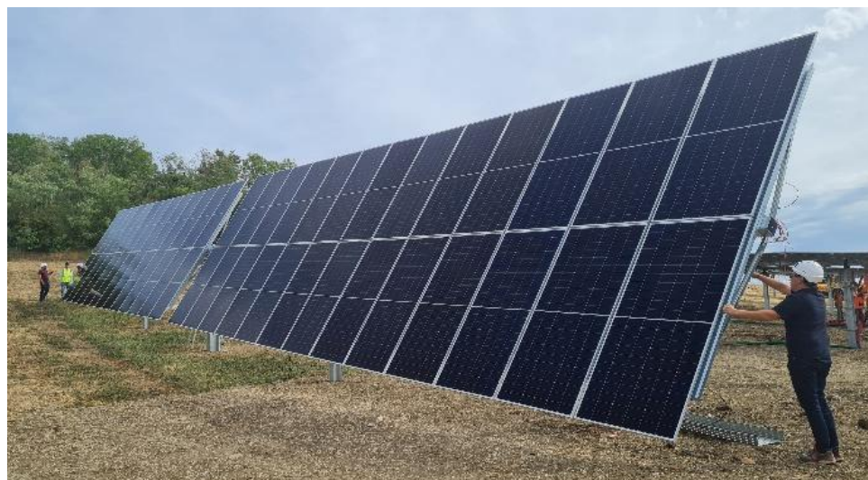
Figure 13 : Installation des panneaux (source : TSE)
