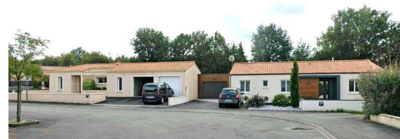
C – Quartier pavillonnaire attenant au site de projet. Les maisons présentent des façades enduites claires dans les tons ocre ou crème, et des toitures principalement à double pente en tuiles orangées. Les menuiseries sont souvent claires.
