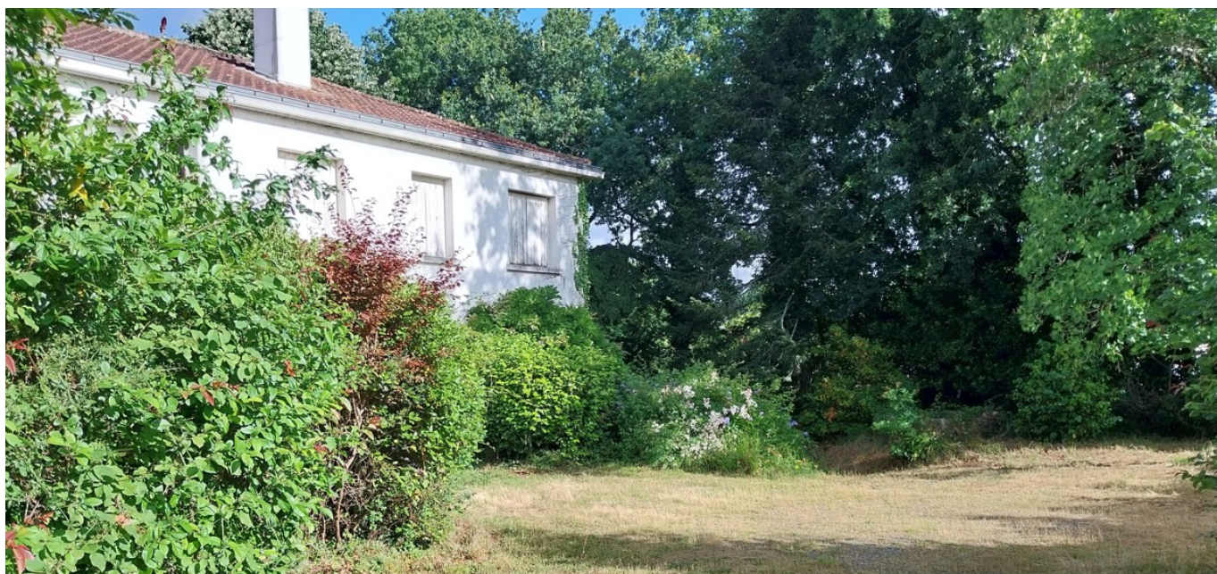
11 : Habitation existante en lisière Nord du site
