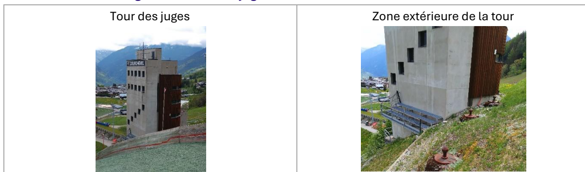
Figure 11 : Tour des juges – Vues des installations actuelles
