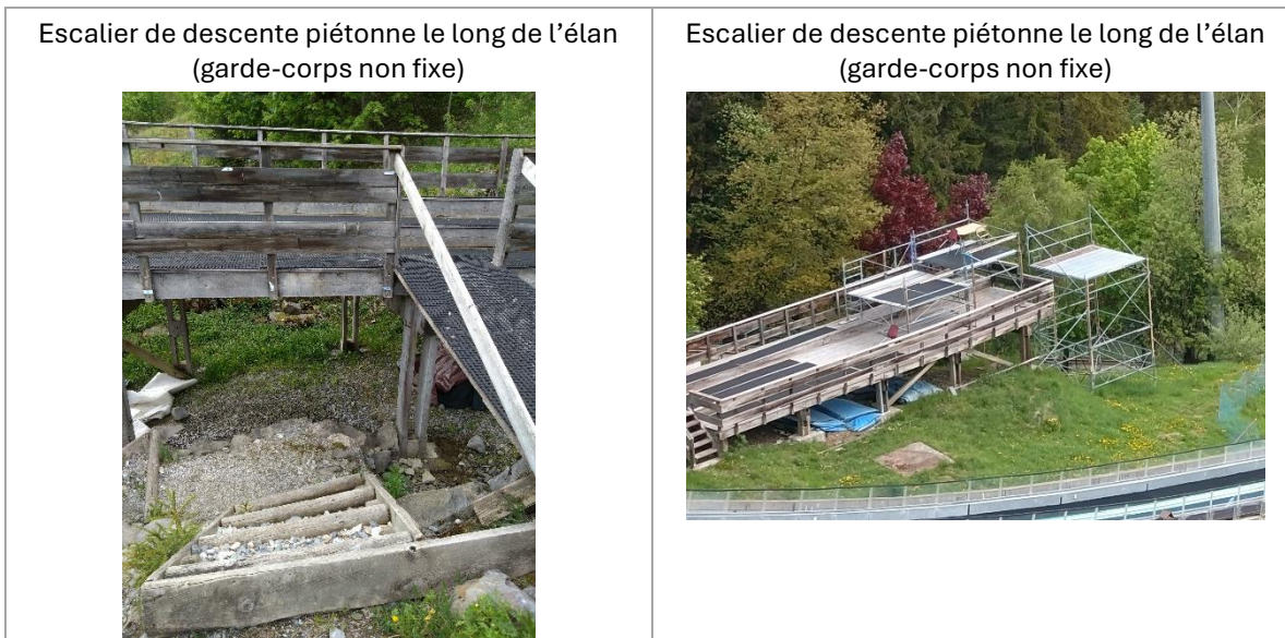
Figure 7 : Plateformes-entraineurs – Vues des installations actuelles
