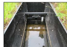
Canal de sortie
