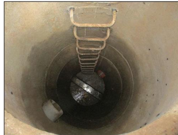
Regard amont cuve - Trop-plein
