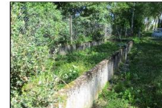
Lit de séchage non utilisé
