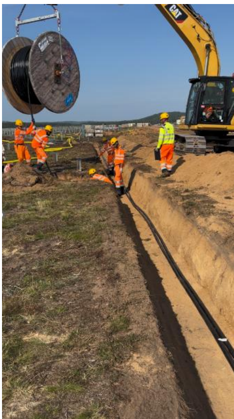
Illustration 11 : tranchée et cheminement de câble
