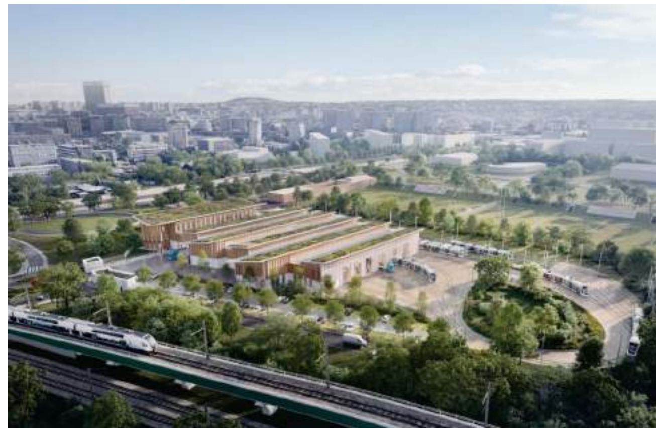
Figure 155 : Vue semi aérienne de l'opération (source : APD)
