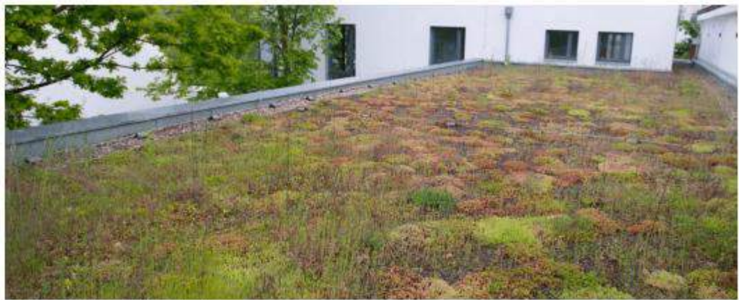
Fig72. exemple de toiture végétalisée extensive
