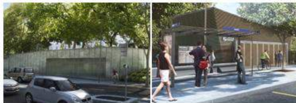
Exemples de locaux techniques (Tram 3)
