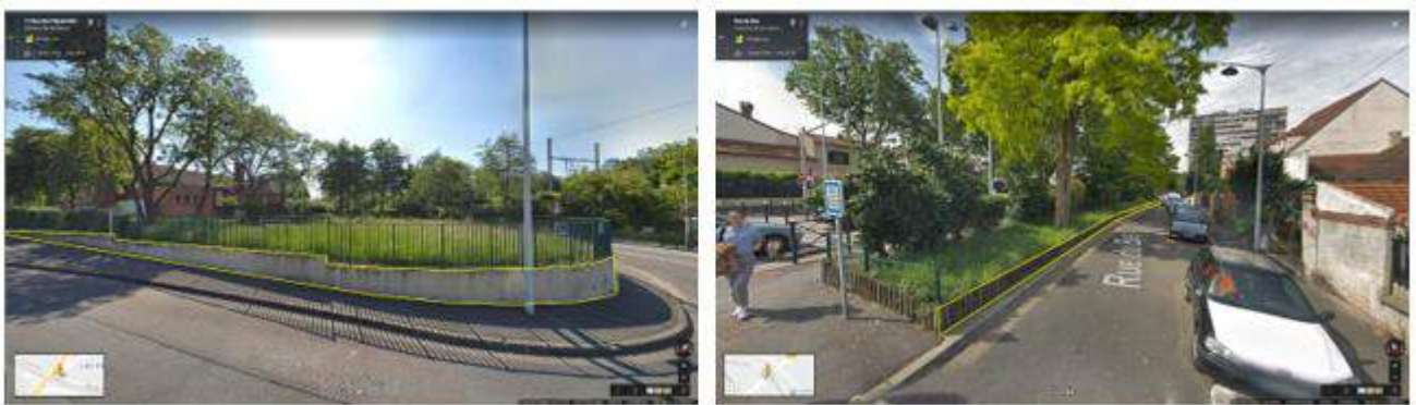
Figure 202 : Exemples de murs à reprendre (zone 1 et zone 4) (Source : Google Maps)
