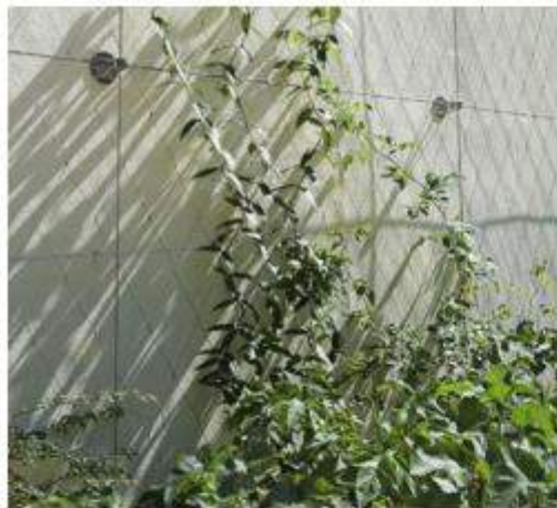
Fig73. Plantes grimpantes sur câbles
