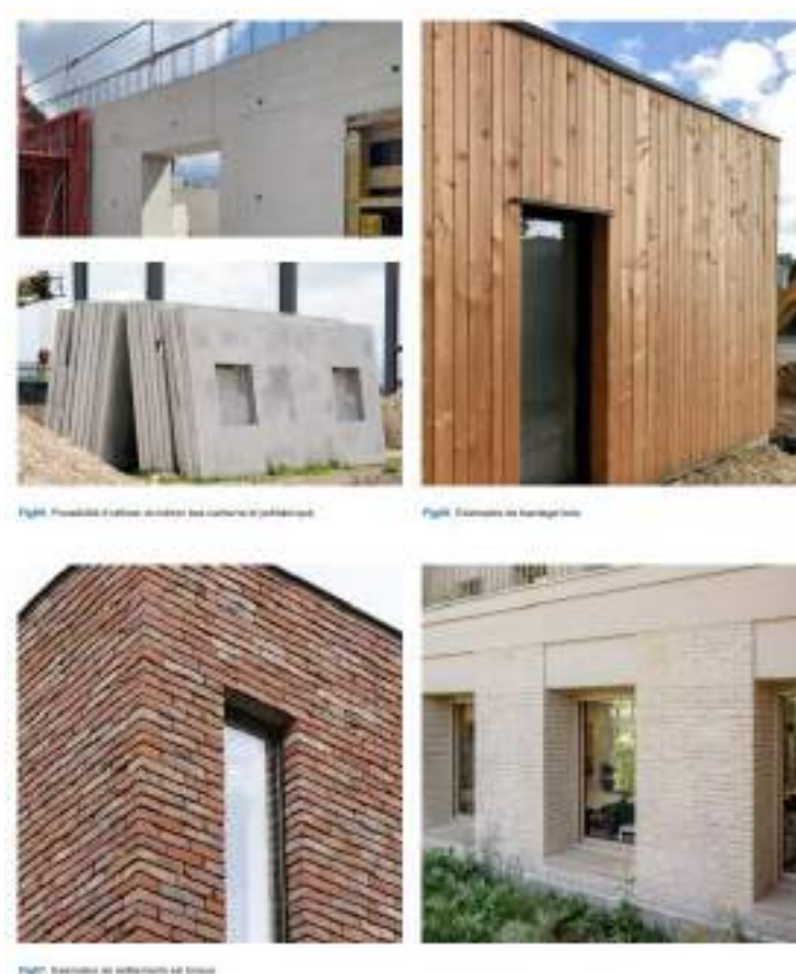
Figure 162 : Type de façades sur les bâtiments en ligne (AVP 2025)
