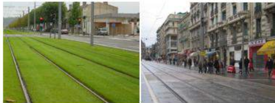
Exemples de plateforme tramway (voie ferrée et revêtement)
