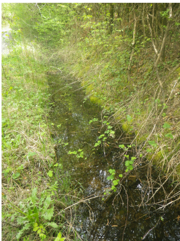
Figure 6: zone humide en pied de talus au Nord.
