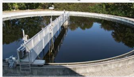
Le traitement des eaux
