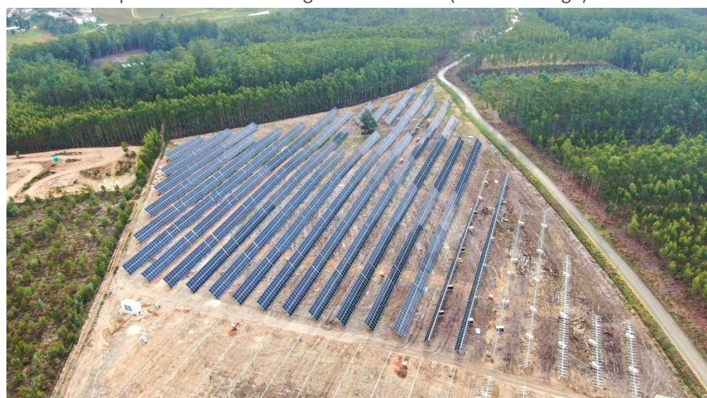
Figure 7 : Centrale de Casal da Cortiça (source : IB VOGT)
