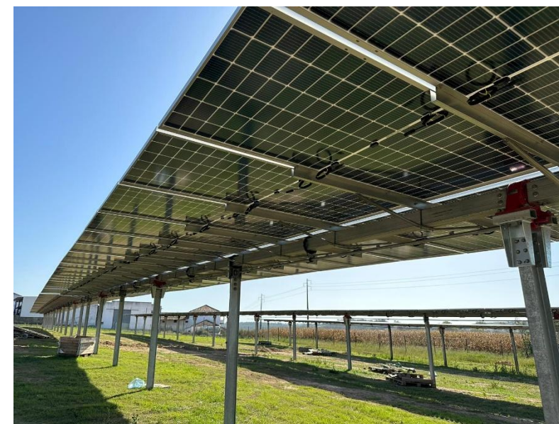
Figure 8 : Structures de trackers monopieux à Casal da Cortiça pendant la construction (source : IB VOGT)
