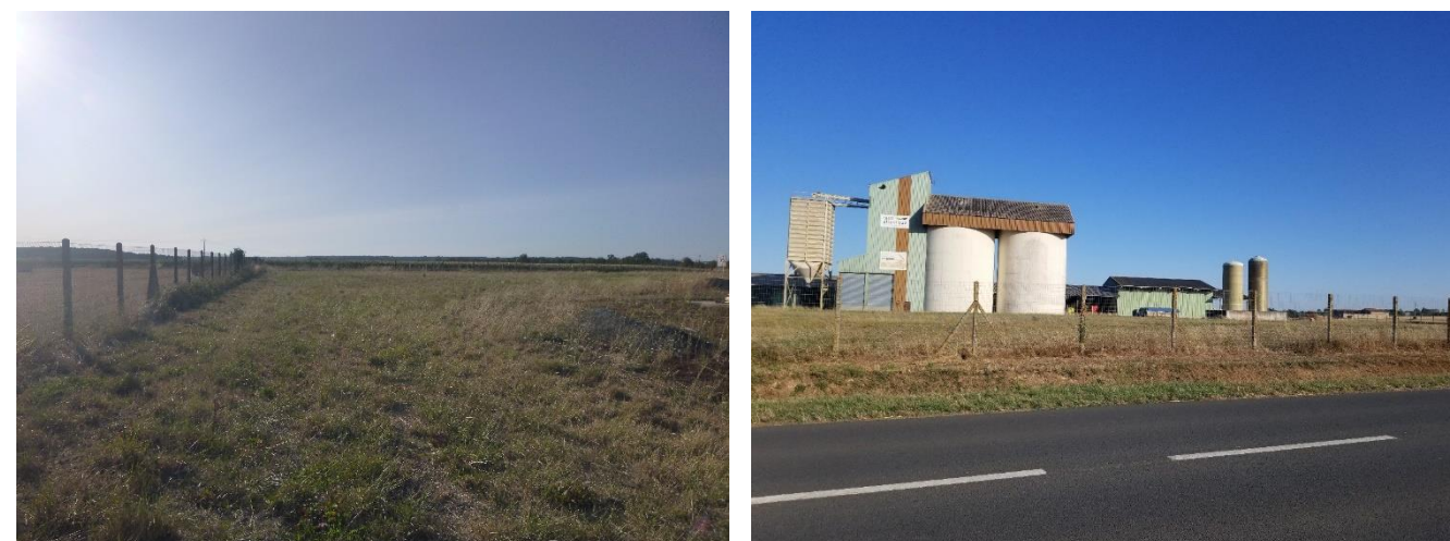
Photographies des clôtures périphériques
