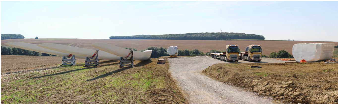
Photo 12 : Eléments d'éoliennes avant montage et exemple de chemin d'accès (Source : Ora environnement)
