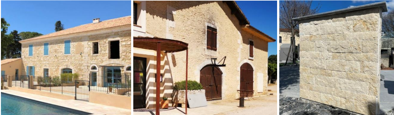
Le château Belle Fontaine et Beaubois et exemple de parements pierre sur un poste de transformation (Source Google)
