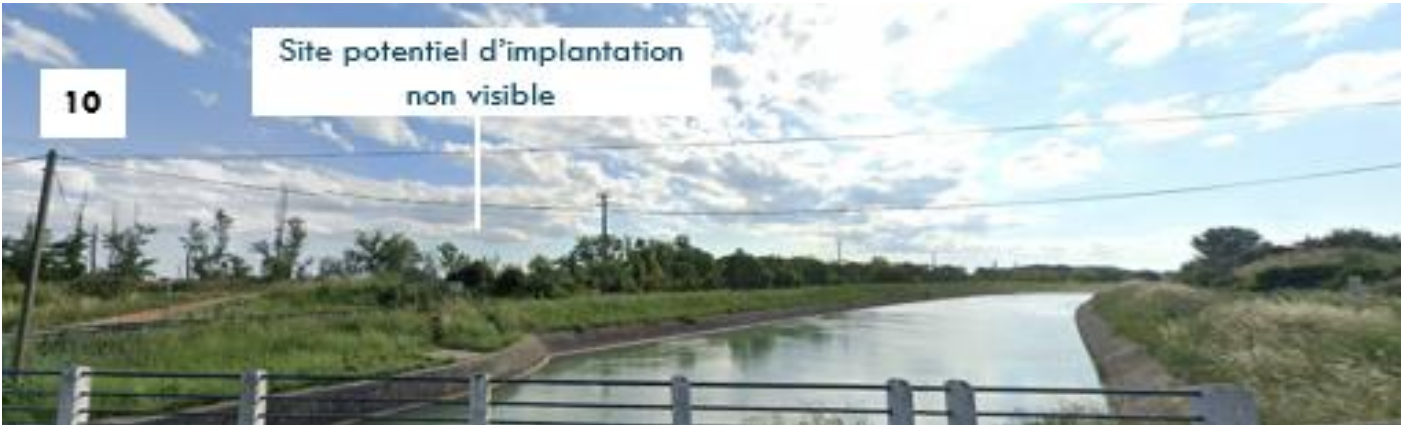
Prise de vue éloignée 10 – depuis le canal Philippe Lamour (Source GoogleStreetView, juin 2024)
