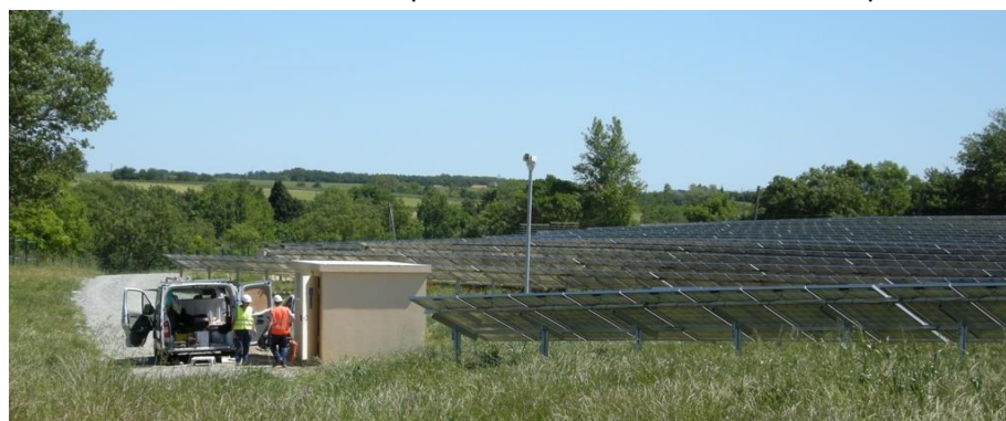
Opération de maintenance
