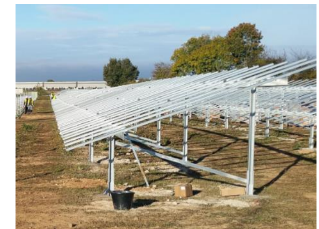
Structures ancrées par pieux forés
