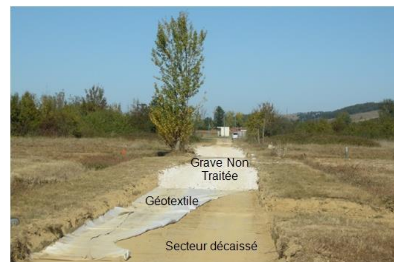
Mise en place d'une voie engins (lourde)
