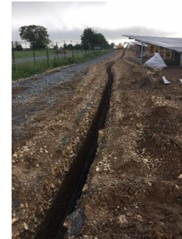
Tranchée pour la pose des câbles enterrés – source : LUXEL
