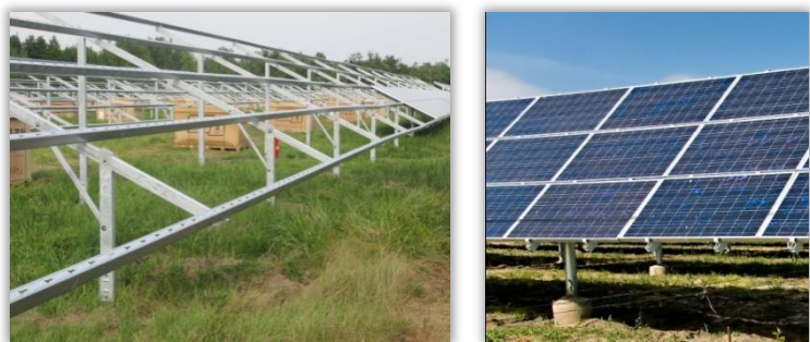
sur pieux sur plots béton Structures porteuses
