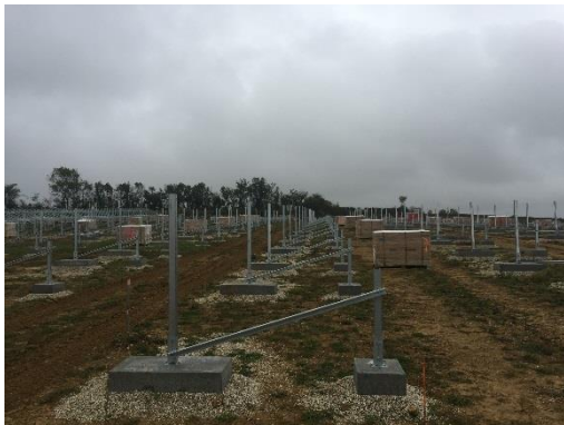
Pose de fondations lourdes - Source : Luxel
