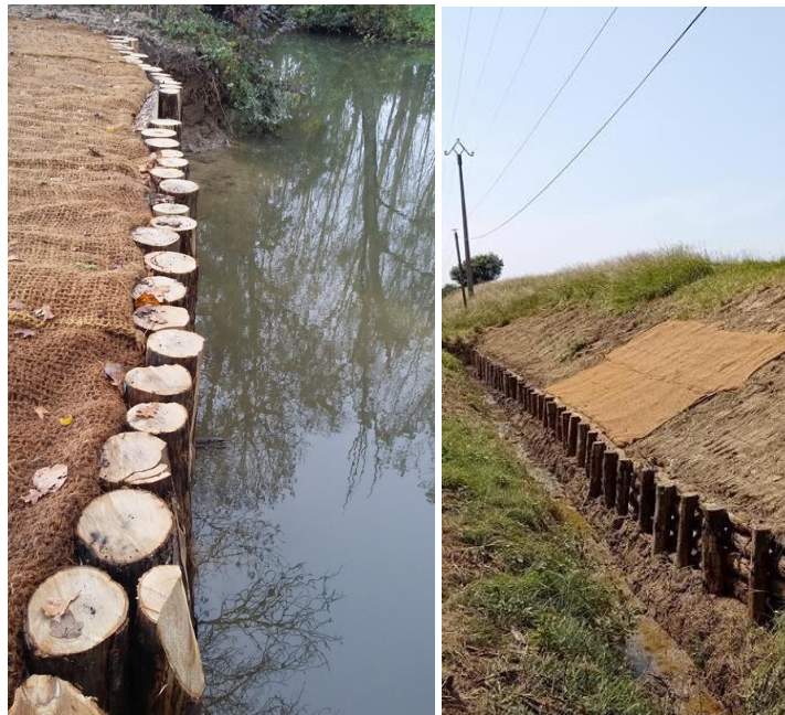
Figure 10 : Exemples de reprise berges en génie végétal, photos travaux, source : RIVES&EAUX
