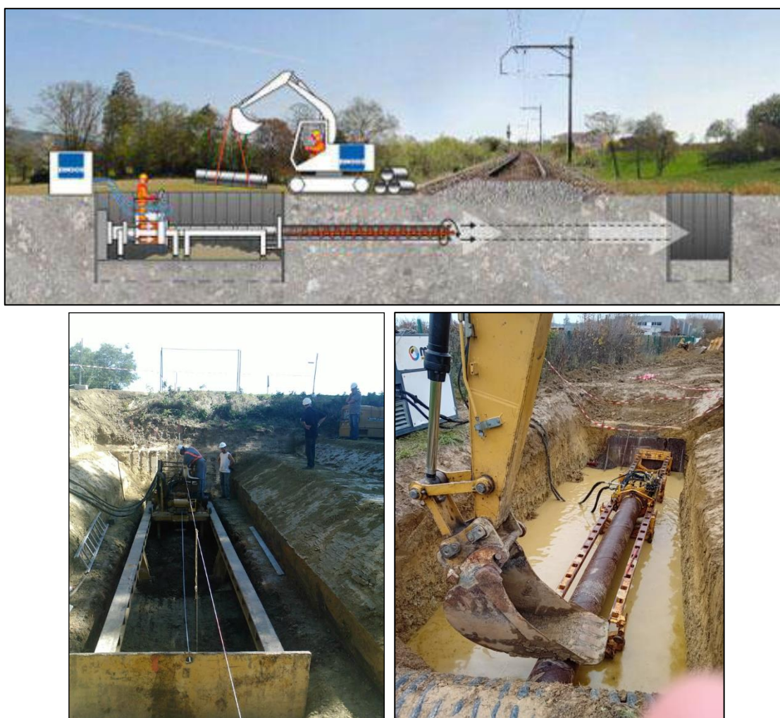
Figure 21 : Exemples de travaux sans tranchée
