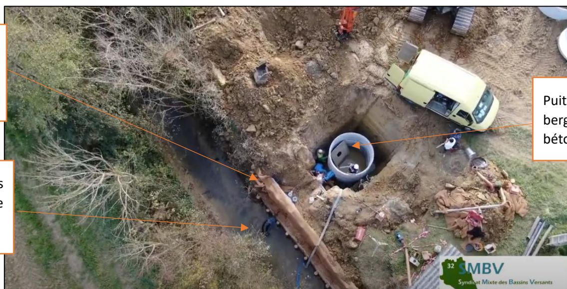
Figure 11 : Travaux de création de puits en berge, source : SMBV Midour Douze
