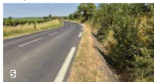
Vue depuis la limite sud du projet limitrophe à la voie départementale n°37
