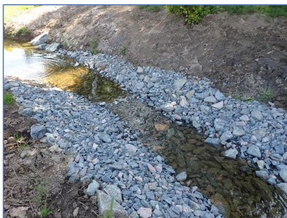
Exemple de réalisation d'un radier par recharge granulométrique sur le ruisseau des Fougères (79)
