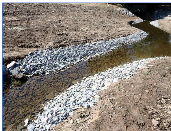
Exemple de réalisation d'un radier par recharge granulométrique sur le ruisseau des Fougères (79)
