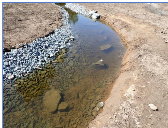
Exemple de réalisation d'un radier par recharge granulométrique sur le ruisseau des Fougères (79)
