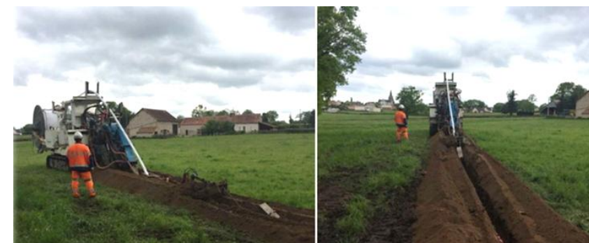
Exemple de chantier d'enfouissement d'un réseau électrique en terres agricoles (source : Cegelec Infra)
