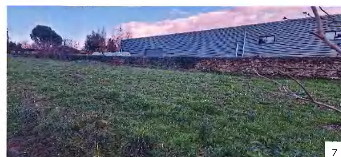
Vue sur l'arrière des parcelles d'activités de la ZA l'Alouette Mur en pierre ceinturant le site.
