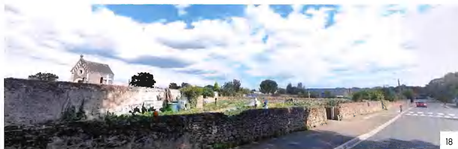
Vue sur l'extrémité Nord-ouest du terrain et son 2eme accès depuis la RD56
