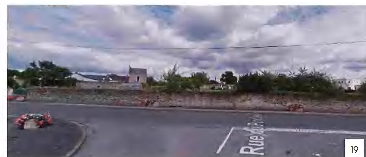
Mur en pierre bordant les parcelles le long de la RD56
