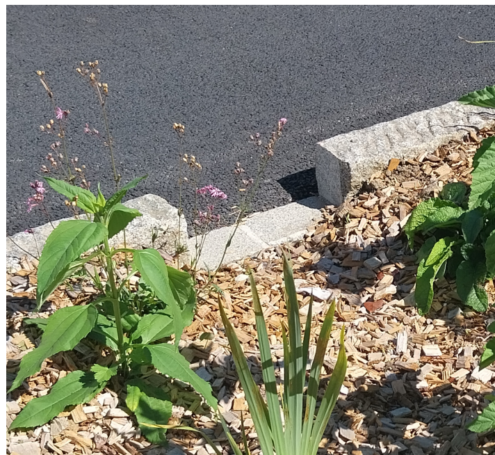
Ouverture dans bordure pour ruissellement de l'eau vers les noues
