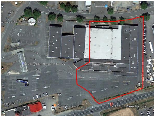
Ancien supermarché Leclerc
