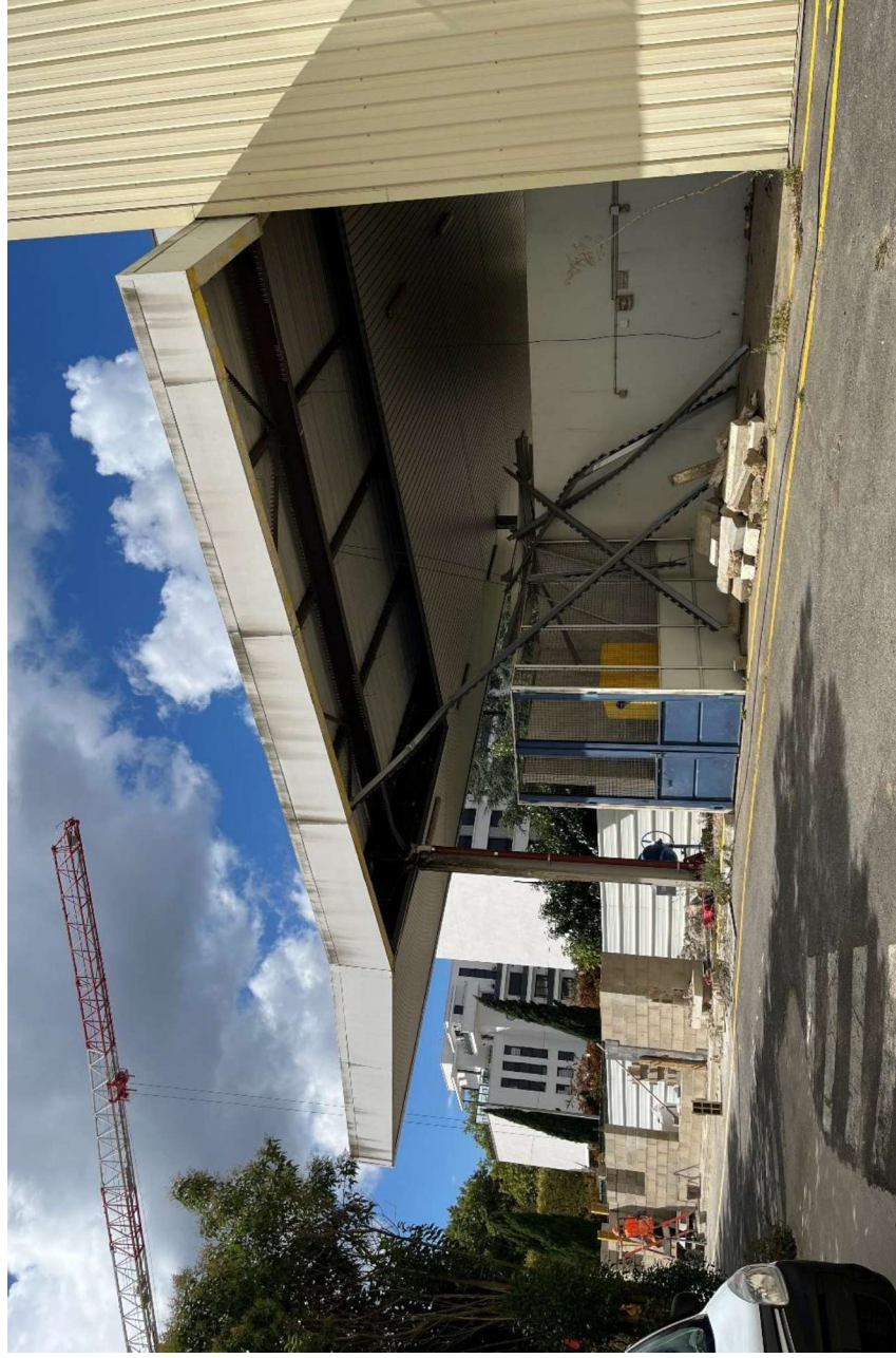
Photographie 5 : Vue sur une partie du bâtiment existant (façade et porche à l'ouest)
