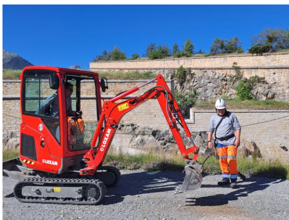
Travail sur le parking devant l'entrée du fort
