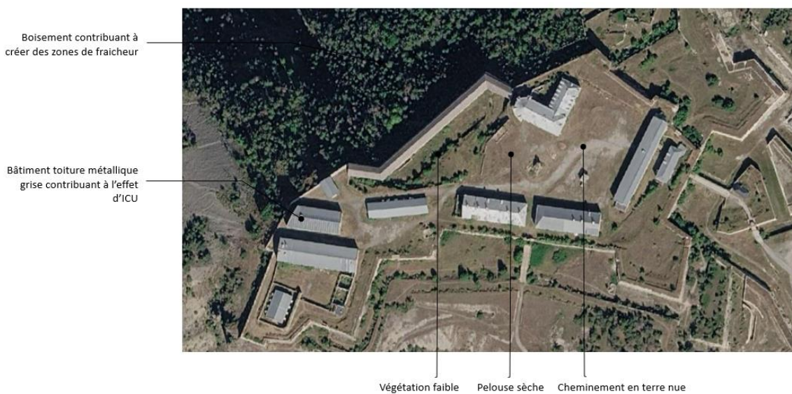
Figure 7 – Vue aérienne – Secteur Fort des têtes
