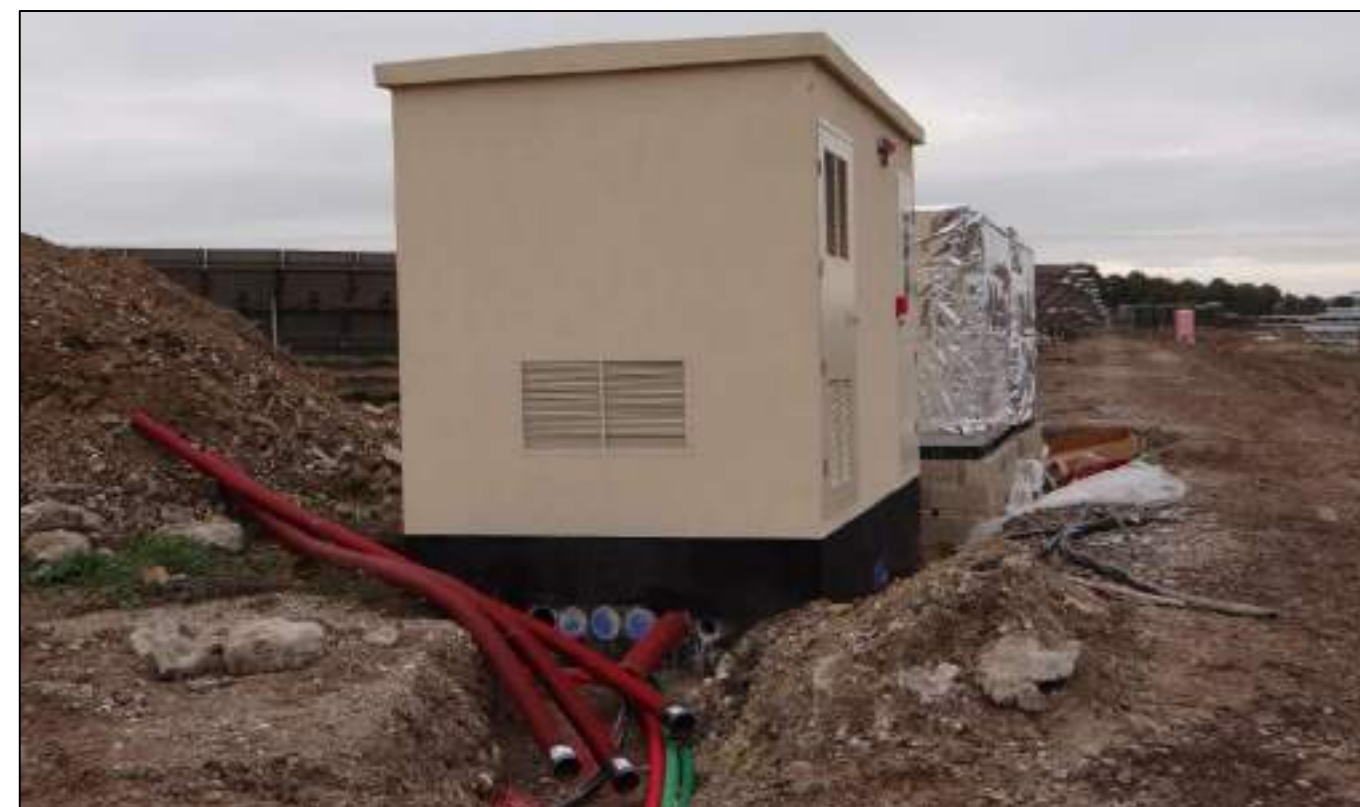
Photo 51 : Installation et raccordement d'un poste de transformation (Source : BEJC)
