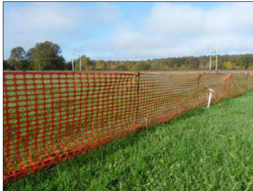
Photo 68 : Illustration d'exemples de balisages de chantier (Source : CERA Environnement)
