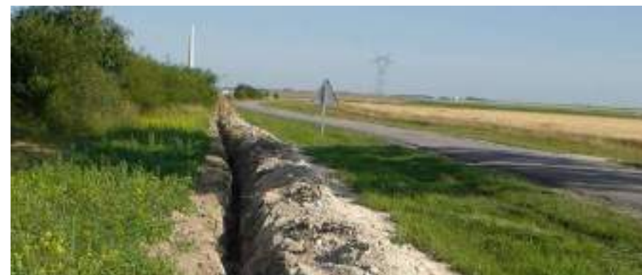
Photo 65 : Réalisation d'une tranchée pour le passage des câbles électriques (Source : BEJC)
