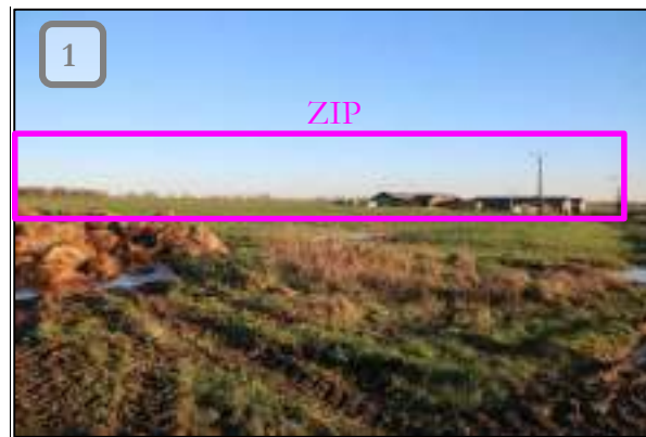
Photo 44 : Ferme de Moisy (Source : BEJC)
