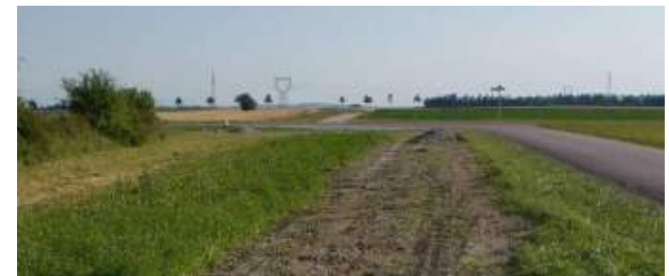
Photo 66 : Rebouchage de tranchée après passage des câbles électriques (Source : BEJC)
