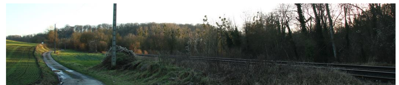
Photo 4 : Voies ferrées depuis la route communale longeant la voie ferrée, à Vauxaillon (Source : BEJC)
