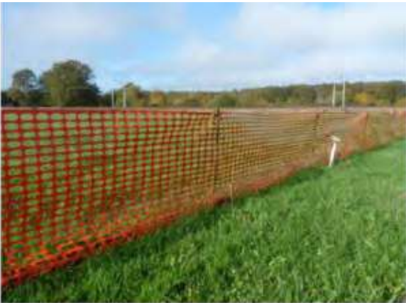
Figure 61 : Illustration d'exemple de balisage de chantier
