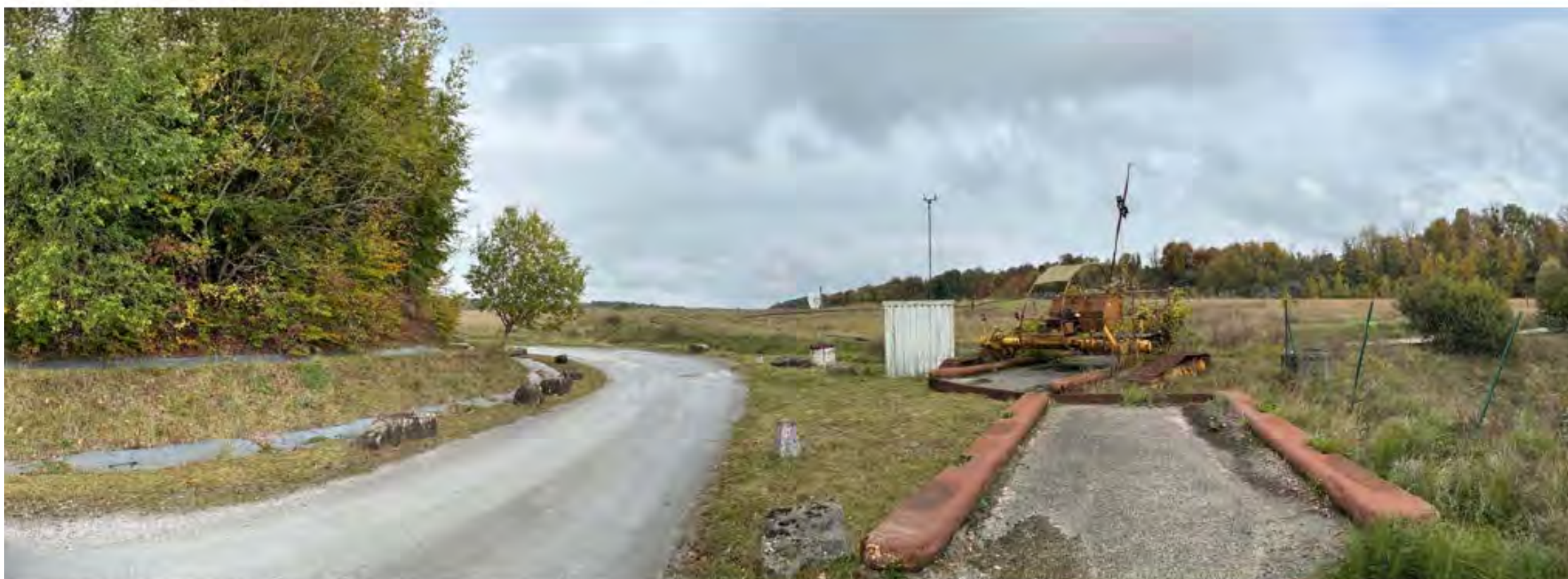
Vue initiale - Bord sud-est de l'emprise n°1
