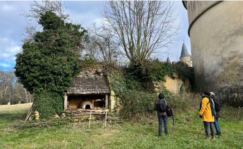
Ancien mur d'enceinte du domaine de Pescheray sur lequel s'appuie le Colombier Un chantier participatif a permis de créer un four à pain encastré
