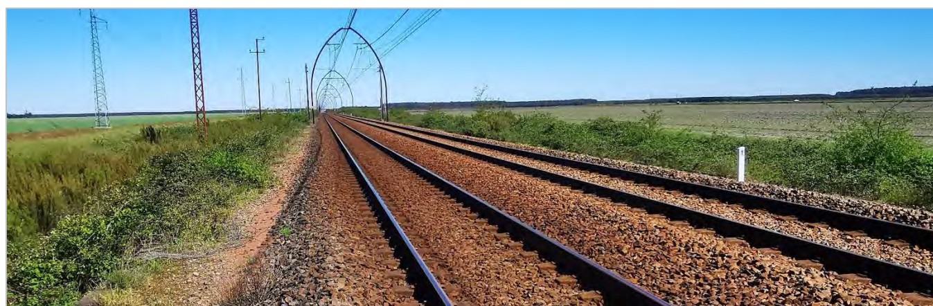
Figure 28. Ballast, traverses, rails, murs de soutènement, talus et fossés, ouvrages d'art constituent autant de micro-habitats favorables à la présence des reptiles.
