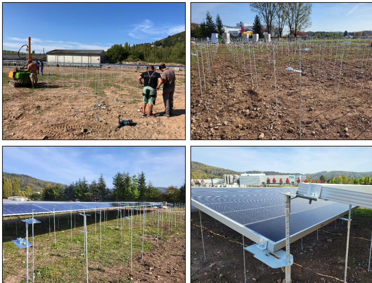
Photo 7: Assemblage des structures sur site – Source : BEC Energy Consult
