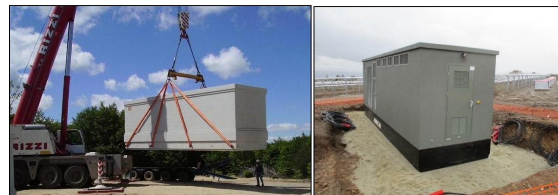
Photo 8 : Installation d'un poste électrique
