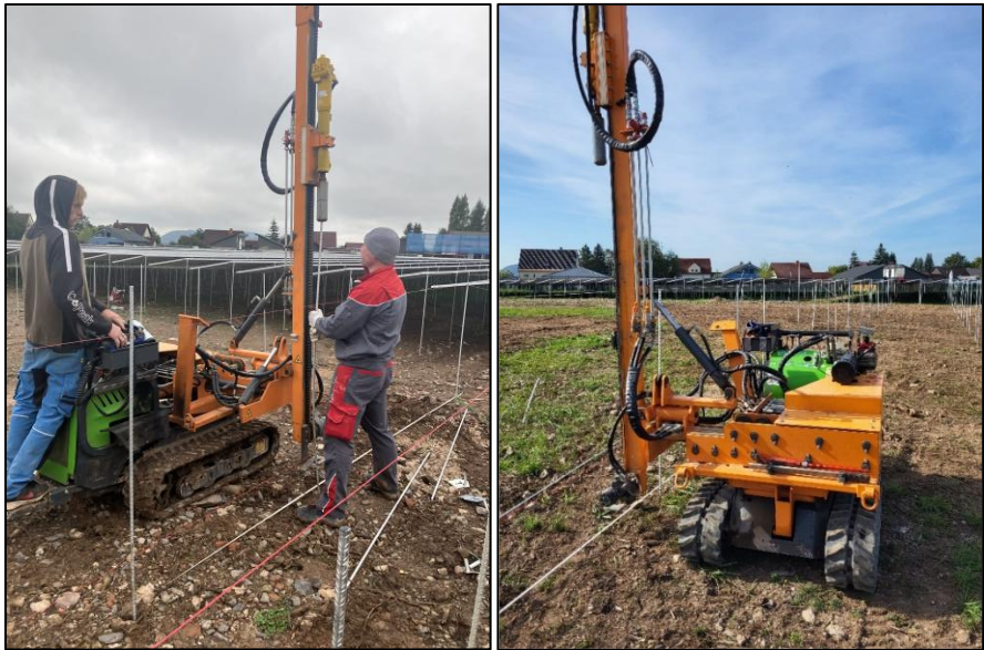
Photo 1 . Sonnette de battage hydraulique
