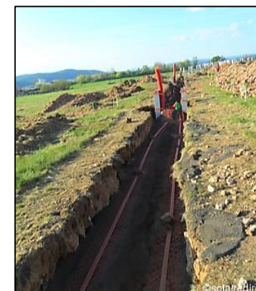
Photo 4 : Tranchée pour câblage
