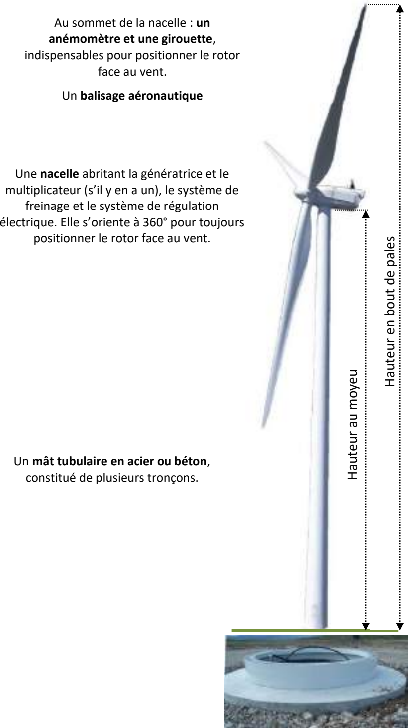
Figure 1 : Les composants d'une éolienne
