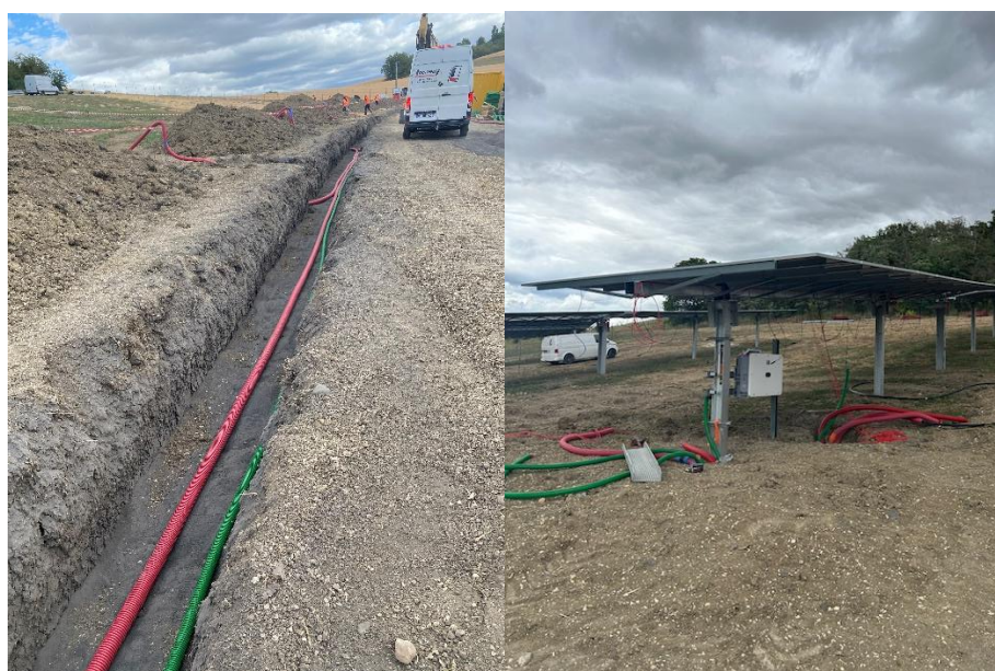
Figure 29 : Illustration de tranchées de câbles (source : TSE)
