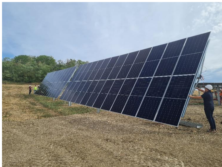
Figure 16 : Installation des panneaux (source : TSE)
