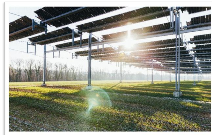
Figure 12 : Canopée agricole construite en Côte d'Or (source TSE)
