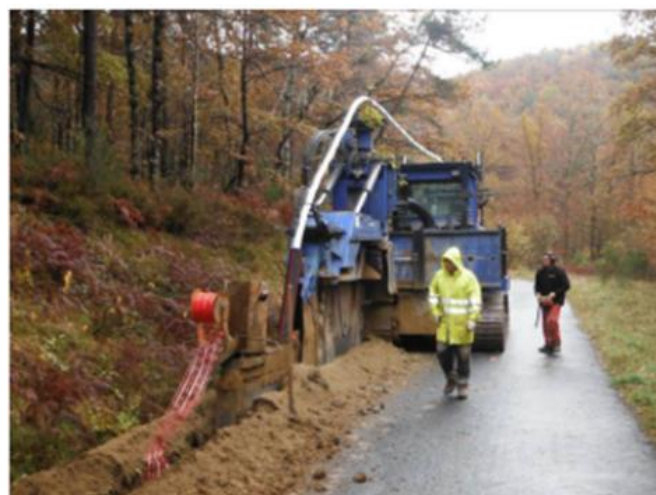
Figure 31 : Pose de câble à la trancheuse
