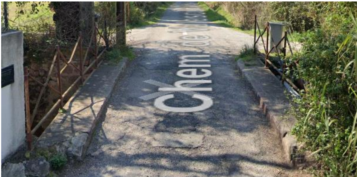
Figure 5 : Photographie du pont du chemin de Valescure (source : Google maps)
