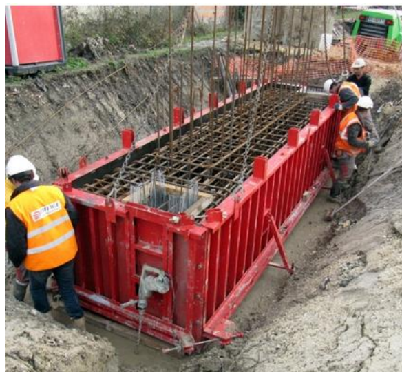
Figure 19 : Exemple de réalisation de chevêtre en béton armé
