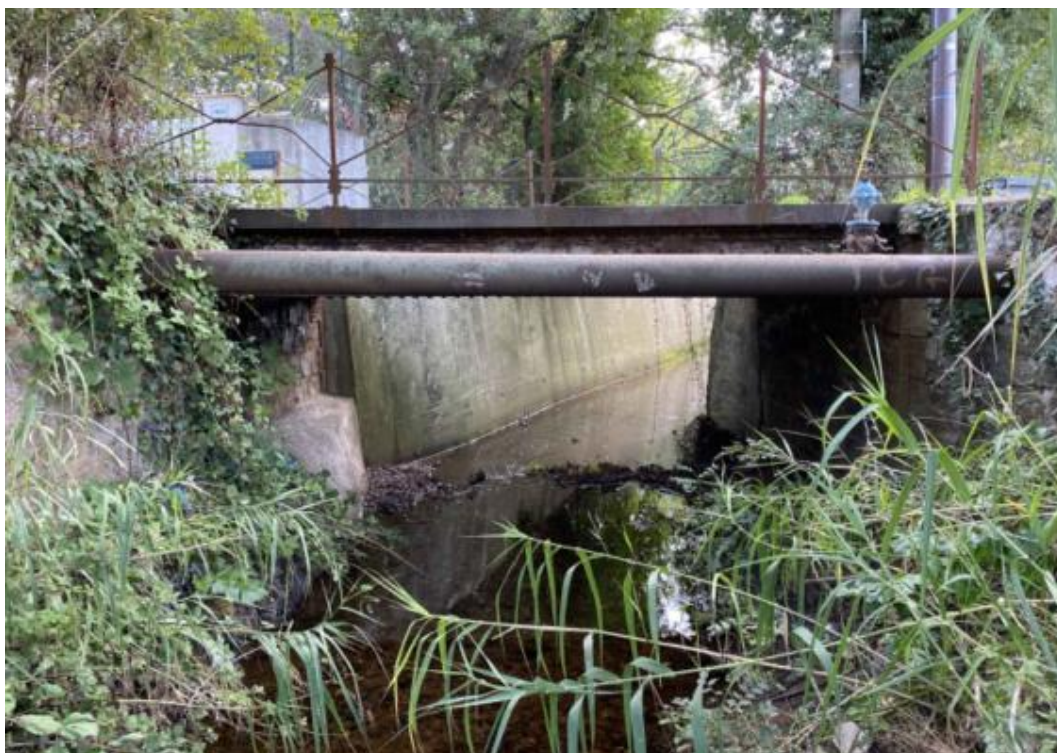
Figure 6 : Photographie de l'ouvrage - Vue côté amont (source : Rapport d'inspection BEMS)
