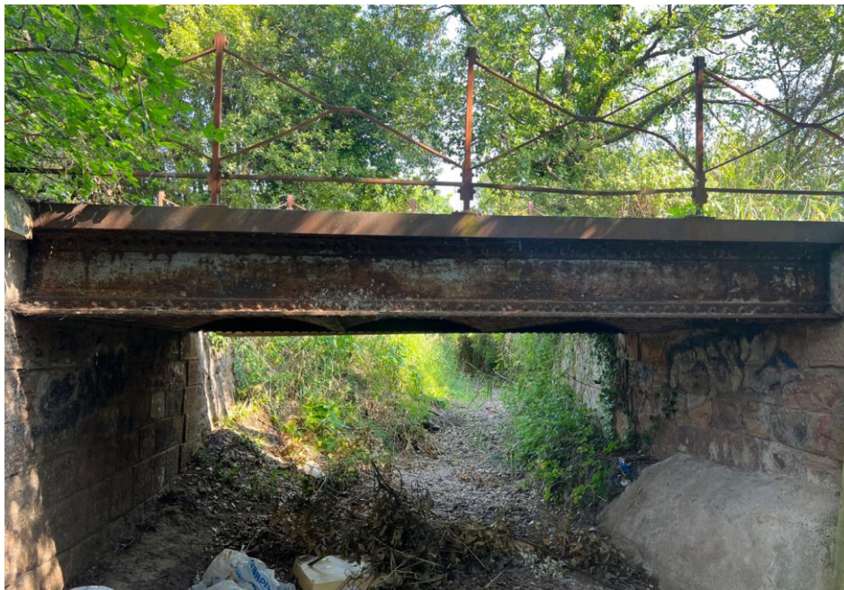
Figure 17 : Vue du tablier à déconstruire
