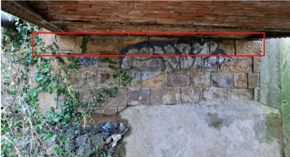
Figure 18 : Vue de la première rangée de pierres maçonnées des culées à déconstruire
