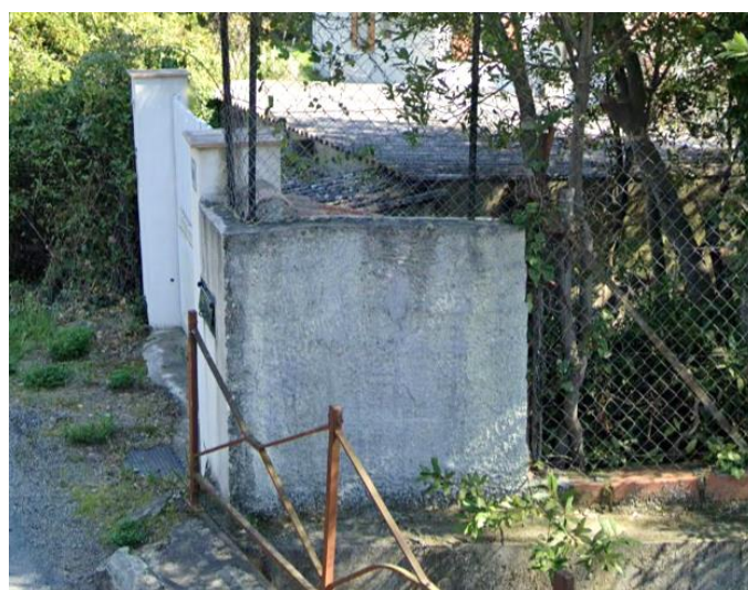
Figure 15 : Vue du mur du riverain au numéro 460 à déconstruire
