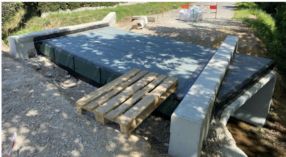
Figure 22 : Exemple d'étanchéité sur ouvrage cadre
