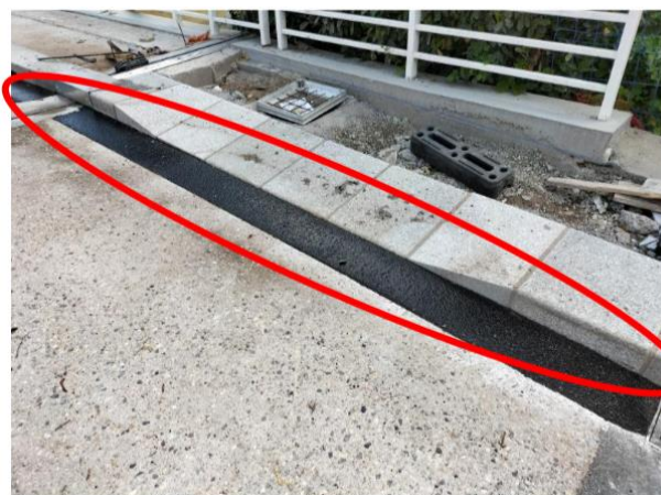
Figure 11 : Caniveau en asphalté en rive de chaussée
