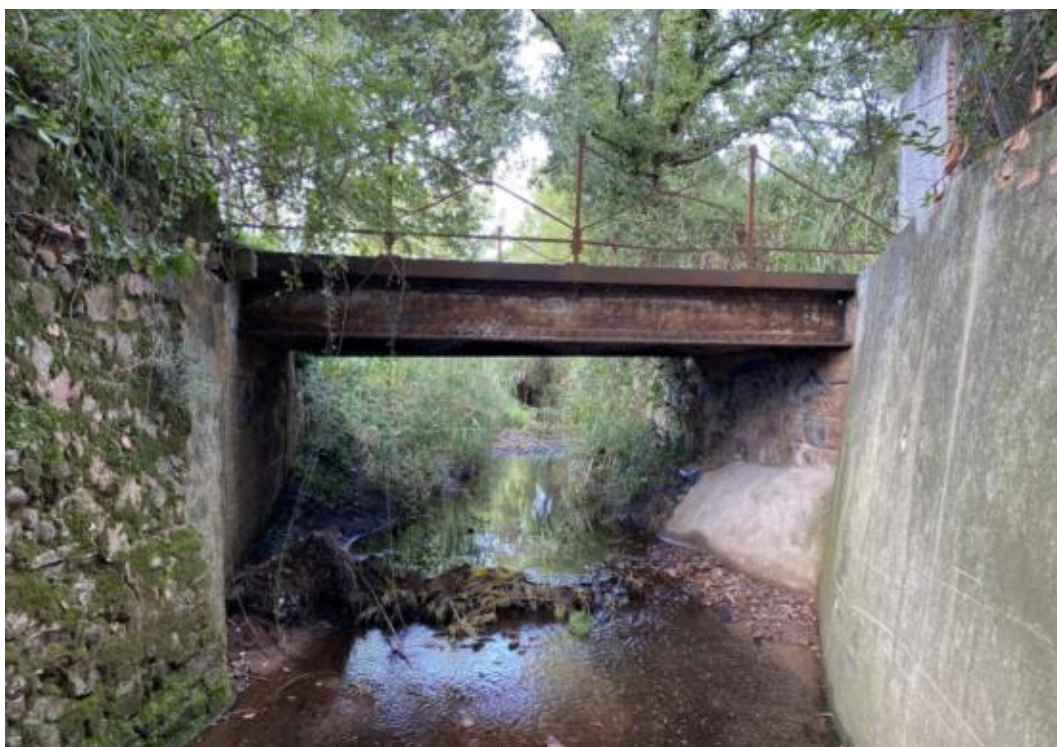
Figure 7 : Photographie de l'ouvrage - Vue côté aval (source : Rapport d'inspection BEMS)
