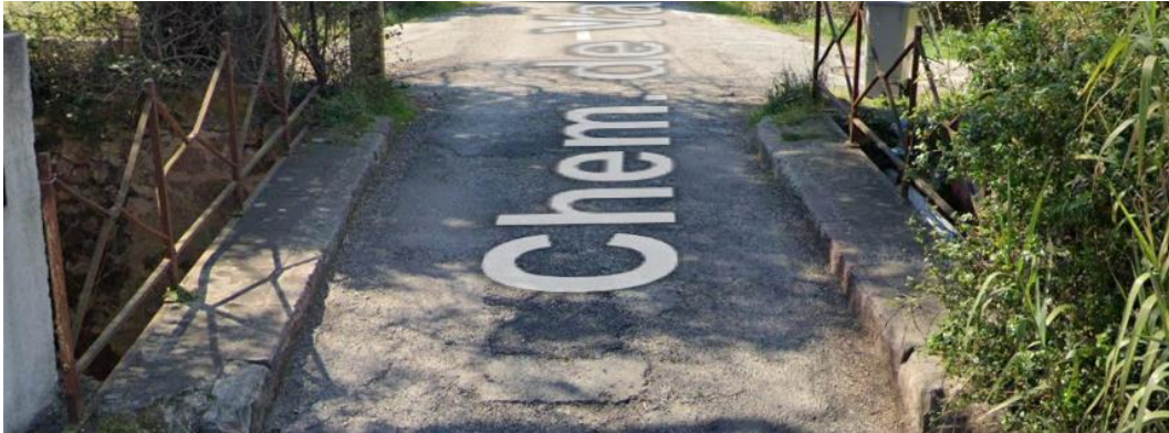
Figure 16 : Trottoirs à déconstruire
