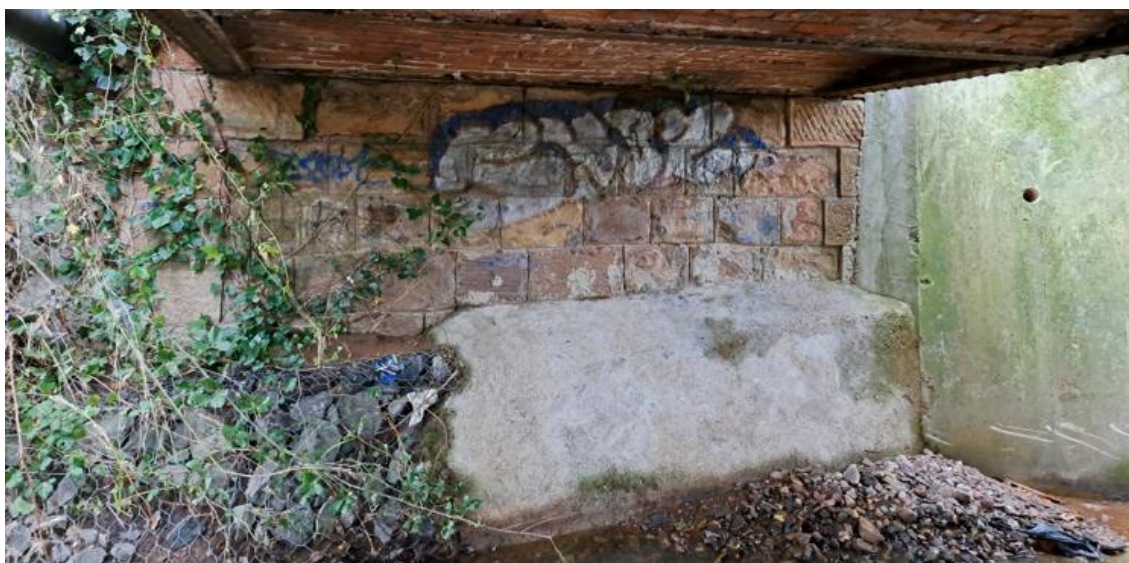
Figure 25 : Gabions existants protégés avec du béton projeté sur la partie droite de la culée
