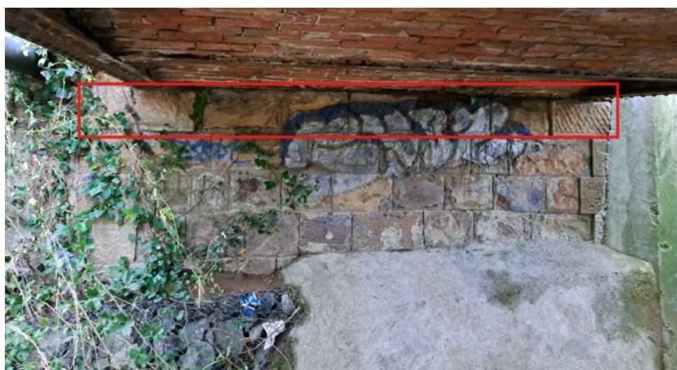
Figure 35 : Vue de la première rangée de pierres maçonnées des culées à déconstruire
