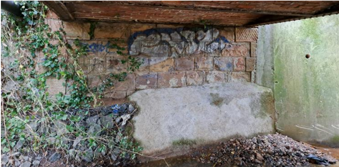
Figure 42 : Gabions existants protégés avec du béton projeté sur la partie droite de la culée
