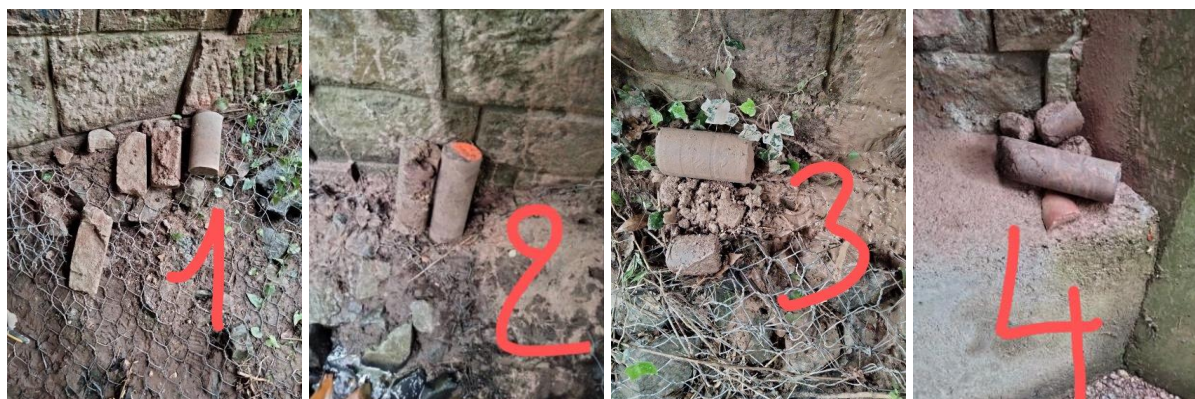
Figure 11 : Résultats des carottages réalisés sur les deux culées de l'ouvrage CF PON 035
