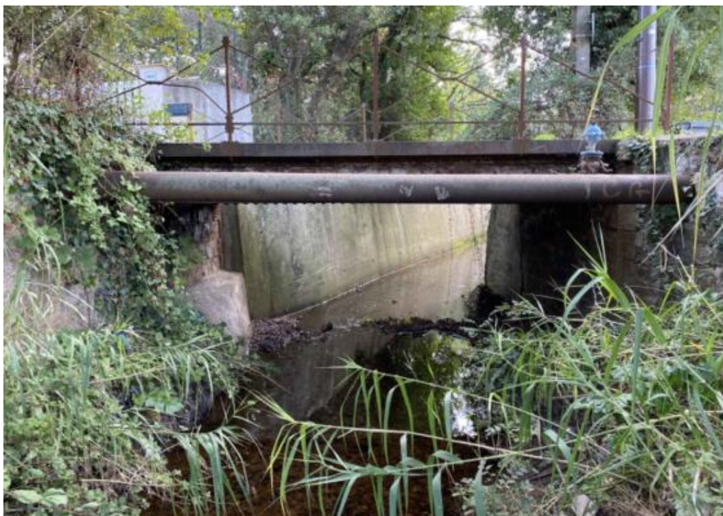
Figure 5 : Vue côté amont
