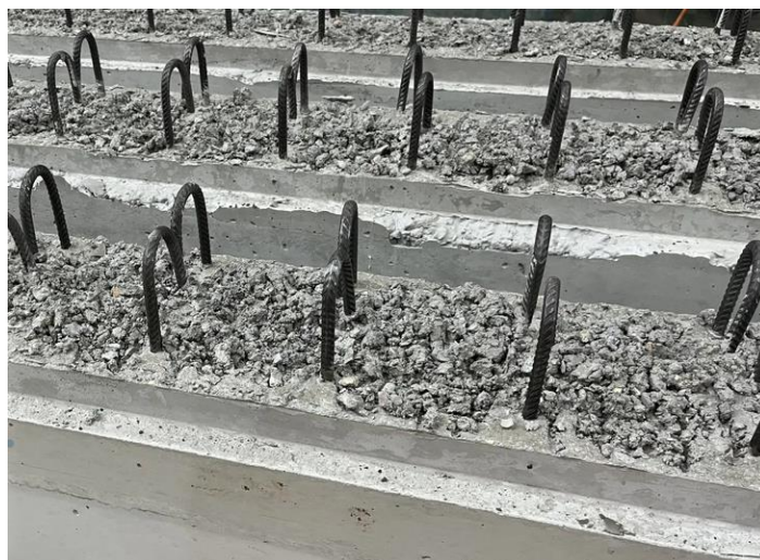
Figure 38 : Exemple de poutres préfabriquées
