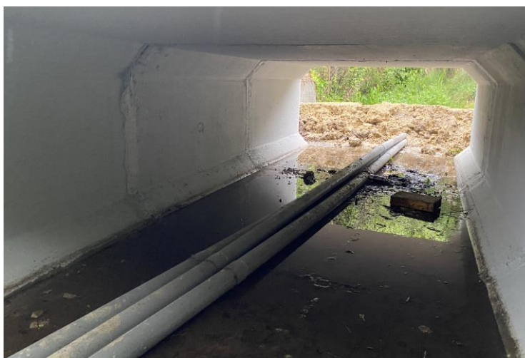
Figure 30 : Exemple de batardeau avec canalisations pour déviation du cours d'eau
