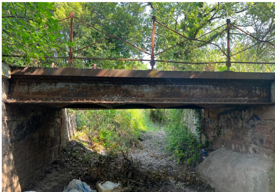
Figure 34 : Vue du tablier à déconstruire
