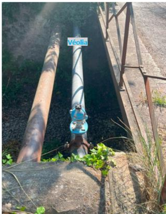
Figure 25 : Canalisation eau potable Véolia parallèle à l'ouvrage
