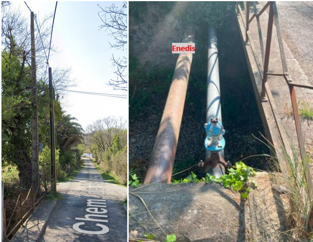
Figure 23 : Réseau Enedis aérien au droit de l'ouvrage (à gauche) et souterrain parallèle à l'ouvrage (à droite)
