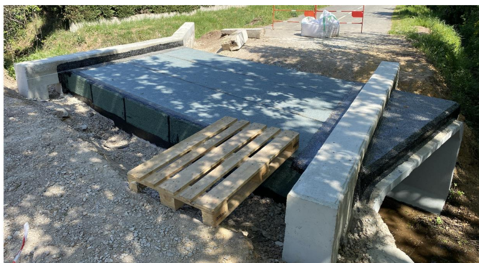
Figure 39 : Exemple d'étanchéité sur ouvrage cadre
