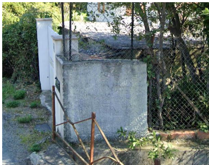
Figure 32 : Vue du mur du riverain au numéro 460 à déconstruire
