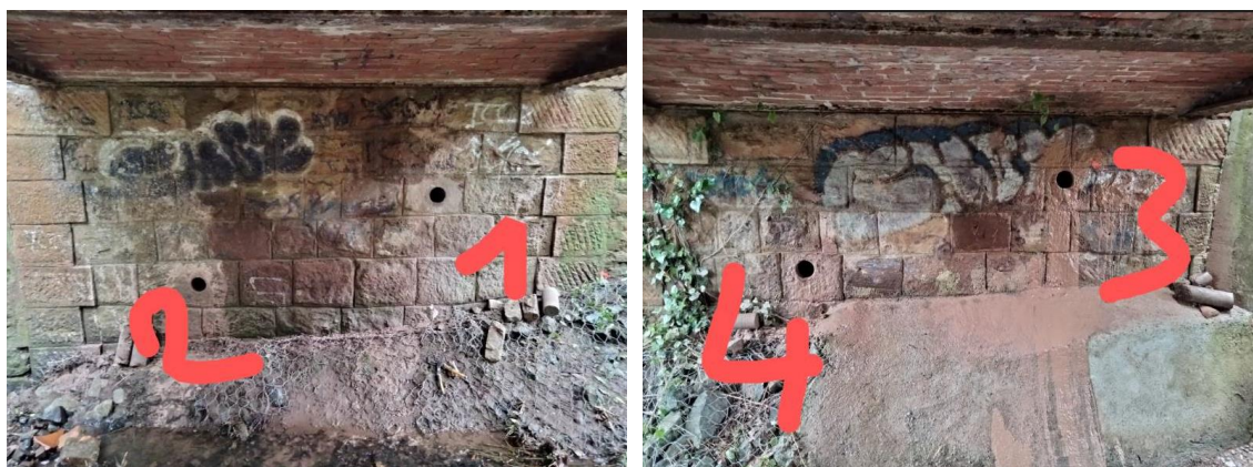
Figure 10 : Carottages réalisés sur les deux culées de l'ouvrage CF PON 035
