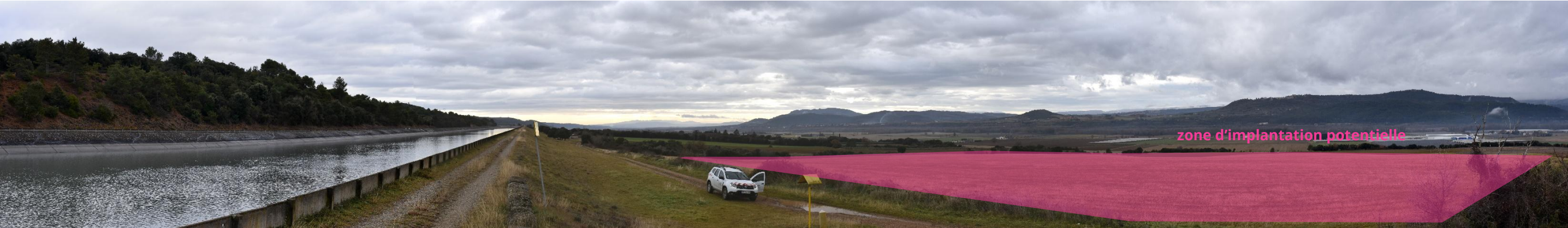
Photographie 10 : Vue sur le canal EDF, sur la partie gauche du panorama et sur la zone d'implantation potentielle, sur la partie droite (vue 1)
