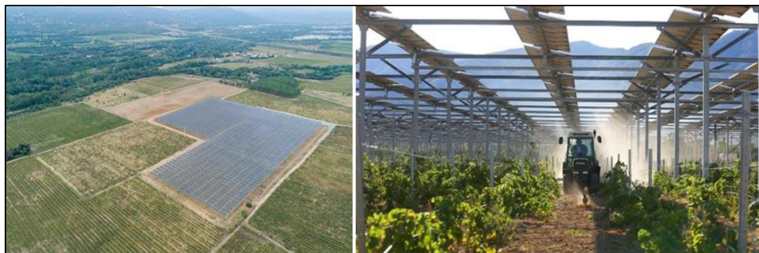
Démonstrateur agrivoltaïque de Tresserre (66) – Domaine de Nidolères
