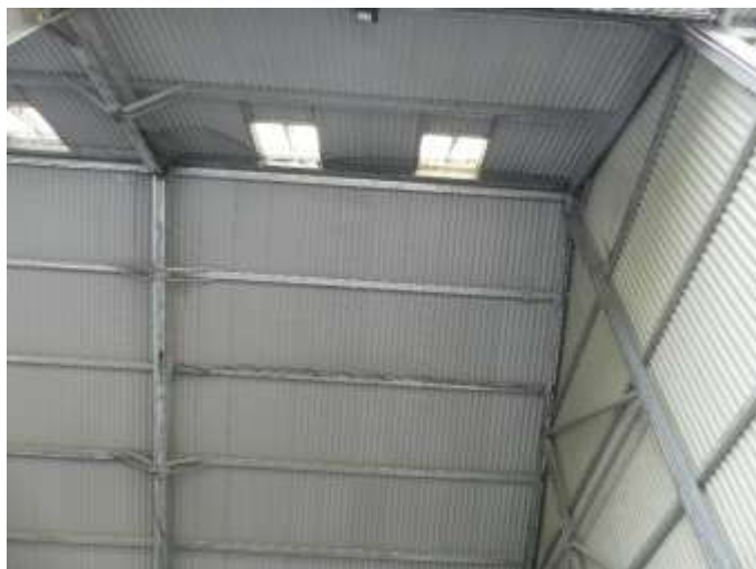
Bâti agricole sur site, exempt de potentialités de gîtes pour les Chiroptères
