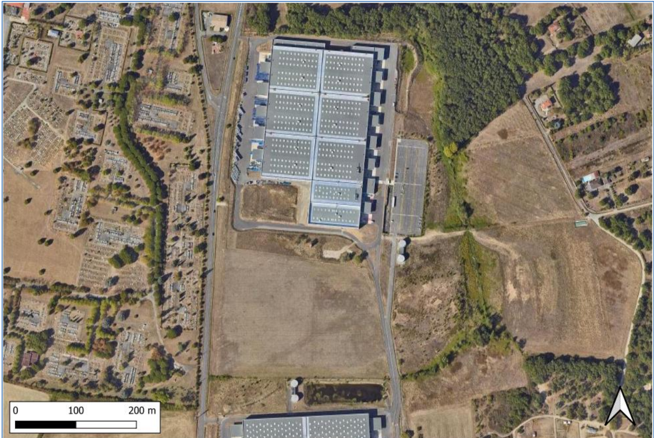
Figure 1 : Vue aérienne du site Airlog II en situation actuelle
