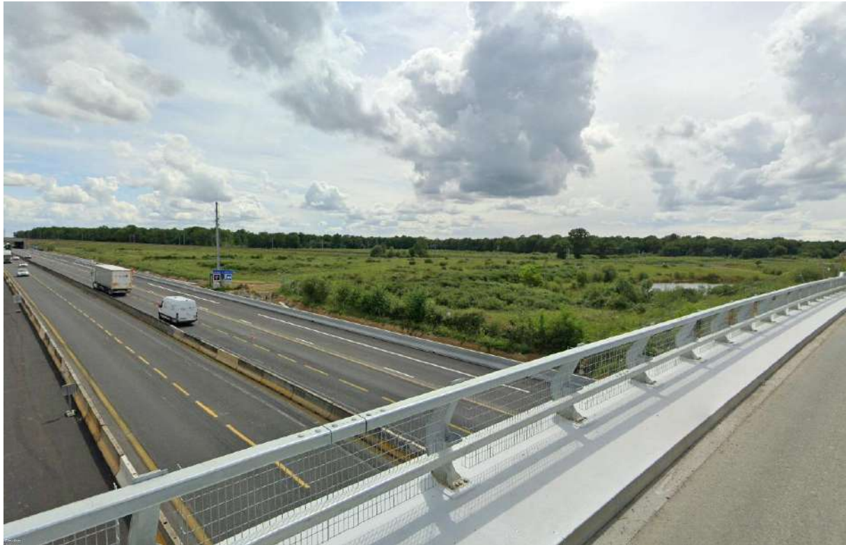
Vue vers le site depuis la voie communale, au nord-est
