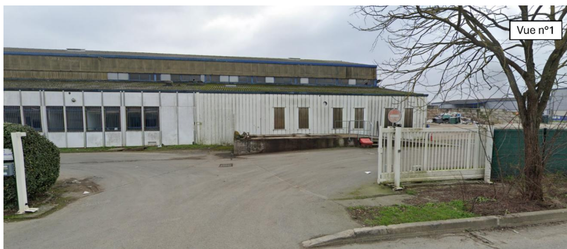
Figure 82 : Vue au nord du site de l'entrée principale véhicules légers depuis la rue Jules Verne (source : Google StreetView, janvier 2023)
