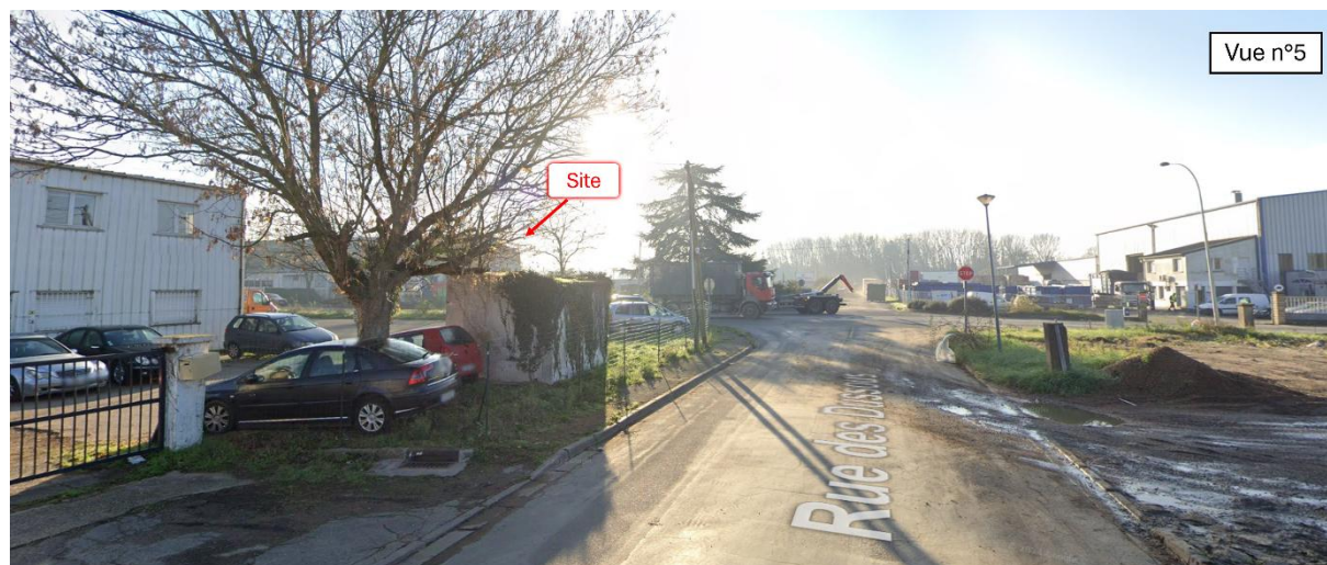
Figure 86 : Vue rapprochée à nord-ouest du site depuis la rue du Dussous en direction du site (source : : Google StreetView, janvier 2023)
