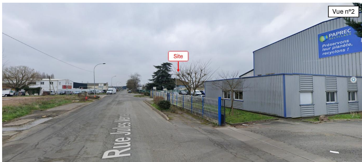
Figure 83 : Vue éloignée à l'ouest du site depuis la rue Jules Verne en direction du site (source : Google StreetView, janvier 2023)
