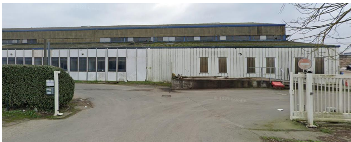
Figure 14 : Vue de l'entrée/sortie et du site pour les véhicules légers depuis la rue Jules Verne
