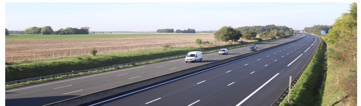
Photo 11 : L'autoroute A10 qui présente très peu de visibilité sur le projet (Source : BEJC)
