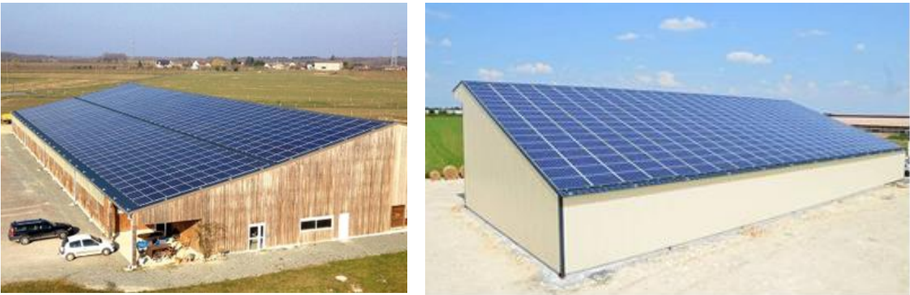
Figure 4 : Quelques références de toitures photovoltaïques du Groupe IEL (A gauche Azay-le-Rideau (37) – 229,32 kWc A droite St-Martin-de-Fraigneau (85) – 99,75 KW) (Source : IEL)
