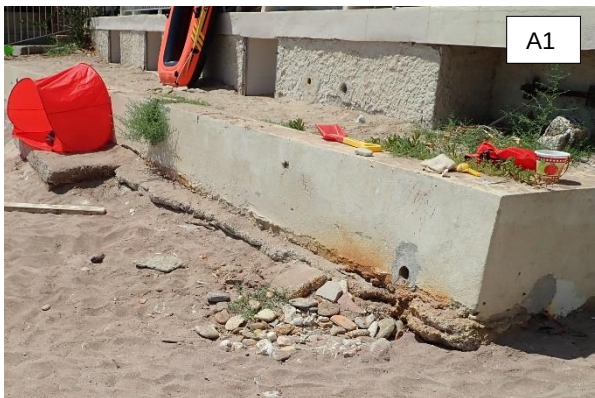
Erosions et dégradations localisées sur le haut de plage
