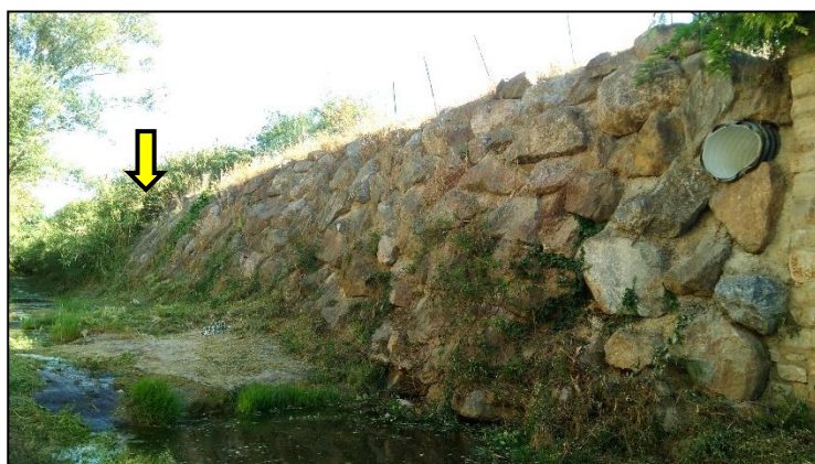
Figure 9 : Vue de l'enrochement existant en aval depuis le Rivassal. La flèche jaune correspond à la limite entre le retalutage de berge et l'enrochement existant.
