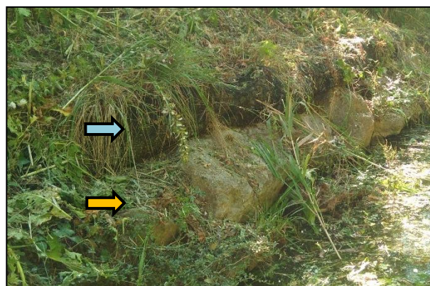
Figure 4: (Haut) Vue du pied berge depuis le Rivassell. Flèche jaune : gabions ; flèche orange : blocs d'enrochement ; flèche rouge : semelle béton (Bas) Vue depuis la berge opposée de la berge à retaluter
