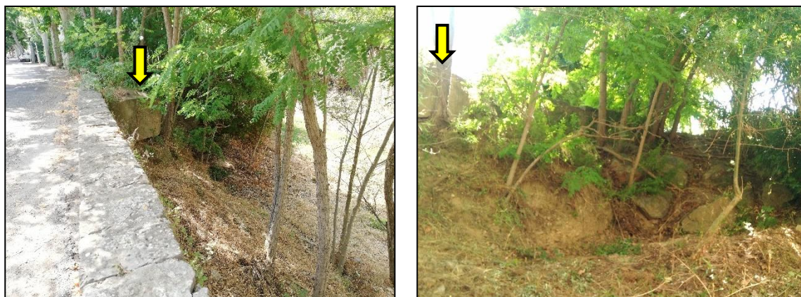
Figure 8 : Vue de l'enrochement existant en amont (gauche) depuis la route et (droite) depuis le Rivassal. La flèche jaune correspond à un repère analogue entre photos.
