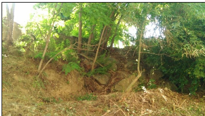
Figure 7: Vue des blocs d'enrochement à déposer en secteur amont
