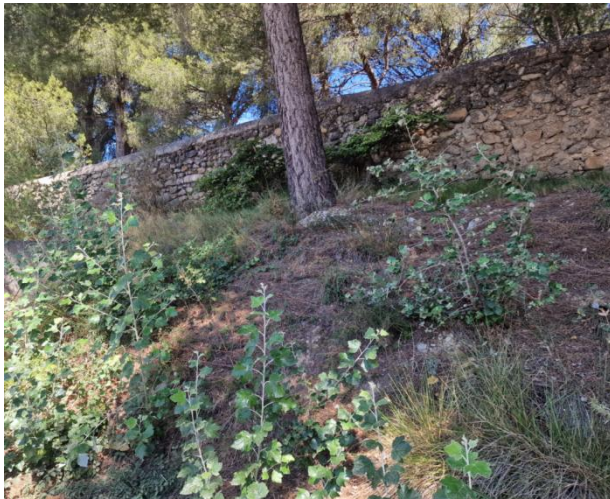
Photo 11 : Mur en pierres maçonnées
