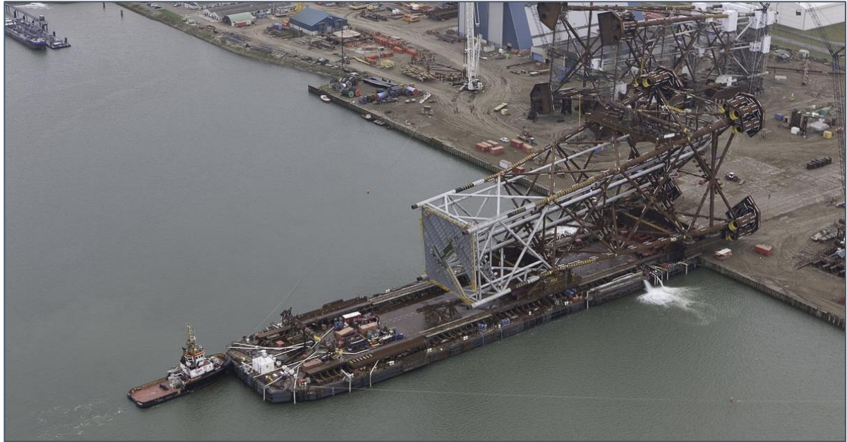
Figure 12 : Sortie du site d'assemblage du jacket (source : HEEREMA)
