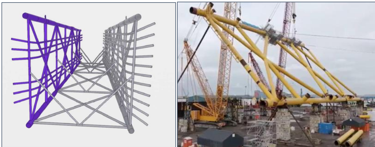
Figure 9 : Face gauche soulevée puis soudée à la face principale
