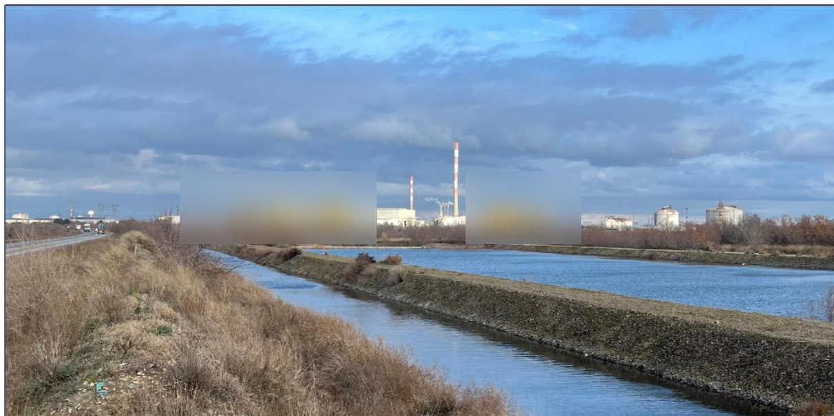
Figure 18 : Site actuel (vue depuis la RD268, depuis l'ouest) (Source : Eiffage Métal) *Pour des raisons de confidentialité, les flotteurs actuellement assemblés sur site ont dû être floutés
