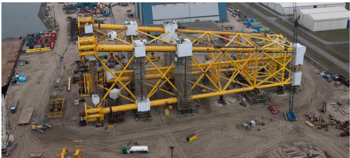
Figure 11 : Exemple de jacket monté au sol. Les zones calfeutrées en blanc correspondent aux zones confinées où les travaux de finition (grenaillage, peinture) sont exécutés (source : HEEREMA)
