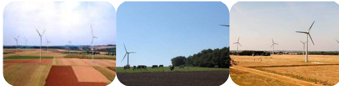
Parc éolien (6) à Maisnières dans la Somme (80) – Puissance de 12MW
