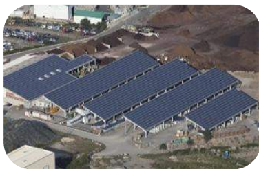
Rénovation toiture et bâti PV – Lavilledieu (07)
