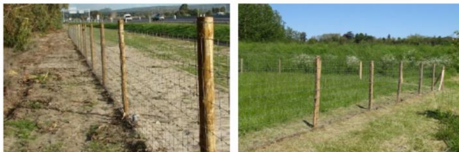
Figure 27. Exemple d'une clôture de parc solaire – Source Melvan
